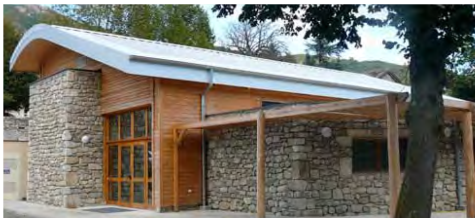
> Après un an de travaux, La Pourette vient d'être inaugurée. Drôle de nom pour une salle polyvalente, diront ceux qui ne savent pas qu'il s'agit d'une variété de châtaigne typique de l'Ardèche cévenole...
